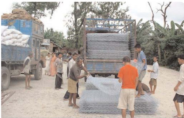
Campamento de refugiados Belangi 1: Descarga de malla de acero que se rellenará con piedra para reforzar las defensas fluviales (proyecto financiado por la Cruz Roja Neerlandesa).
