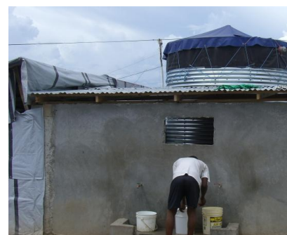
La FICR a terminé la construction d'un réservoir qui permettra aux commerçants de vendre de l'eau aux résidents du camp. Source: FICR
