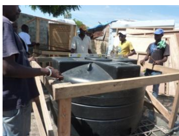
Installation de latrines à réservoir surélevé Source: IFRC
