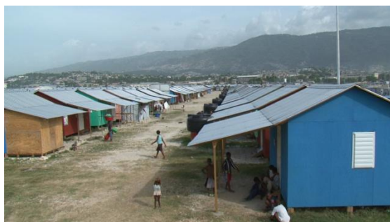
Logements de transition construits à La Piste Source: FICR
