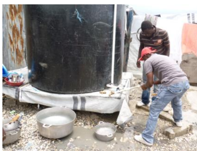
Réparations des points d'eau et des réservoirs Source: FICR
